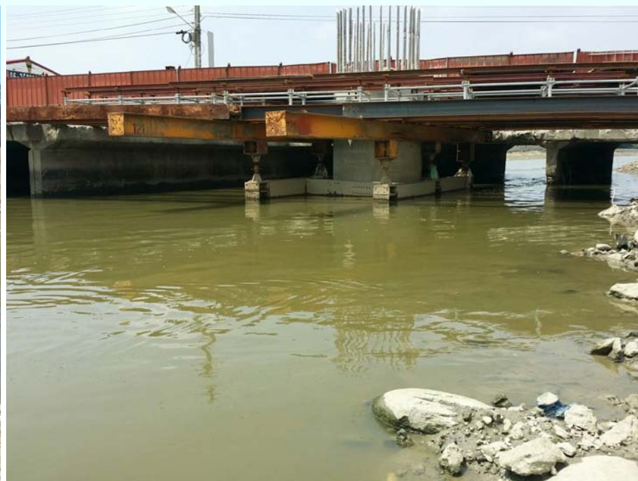
潮見橋改建工程下游端現況
