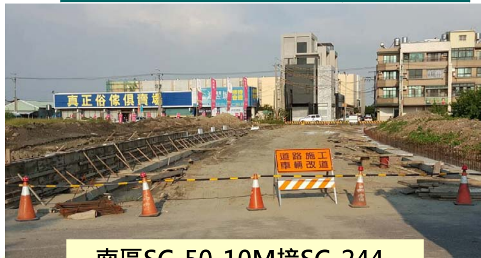
南區SC-50-10M接SC-244-12M道路工程
