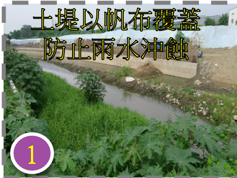
土堤以帆布覆蓋 防止雨水沖蝕
