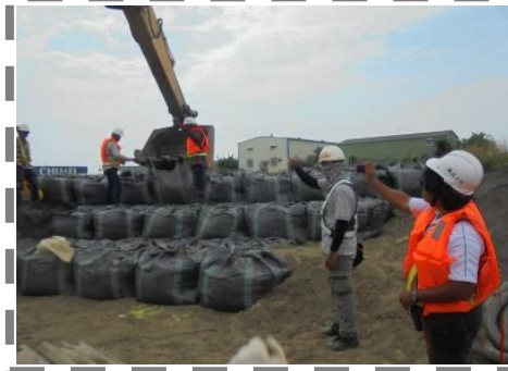
土堤破損模擬演練
