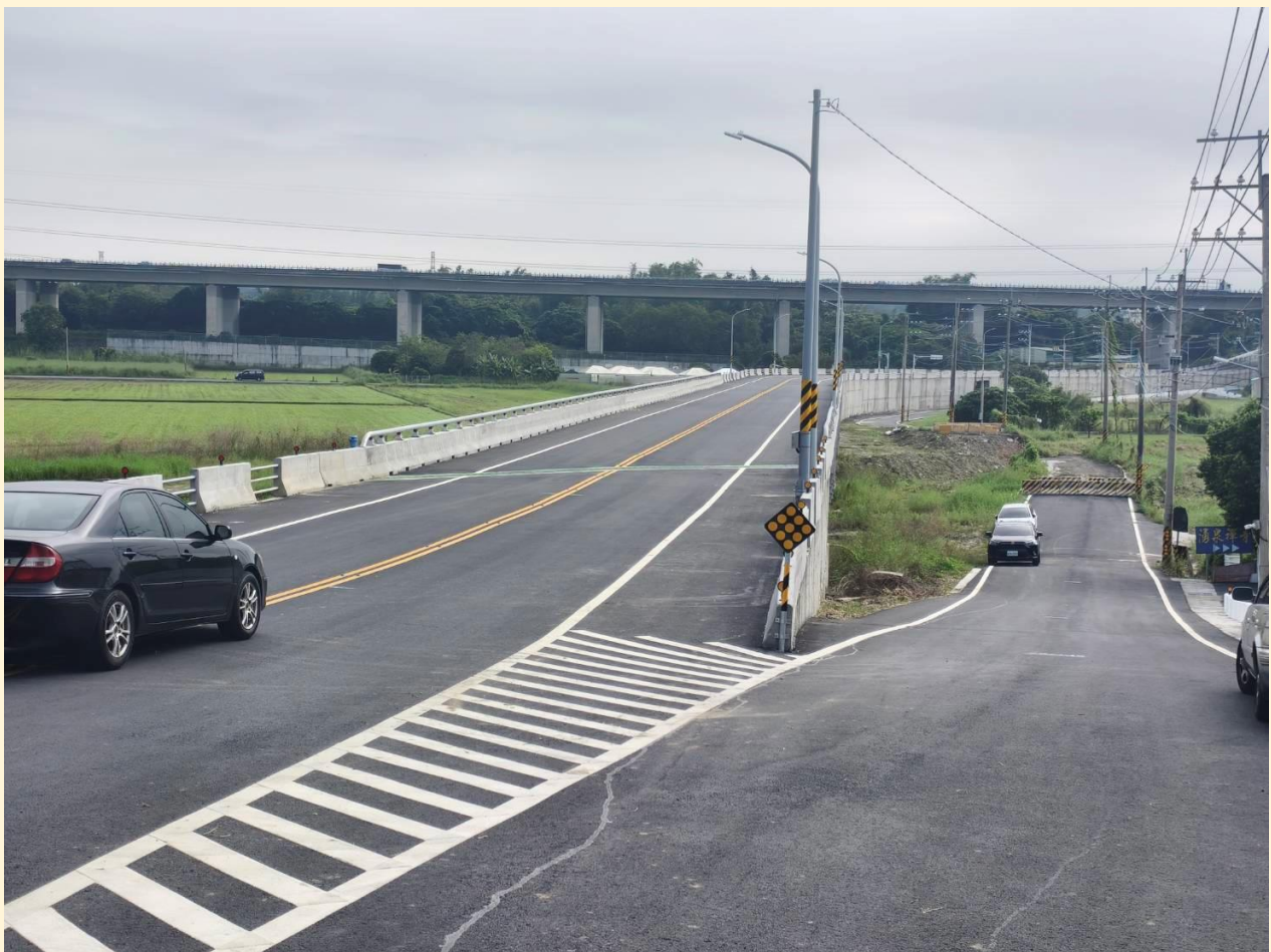
照片 2、菩提橋完工
