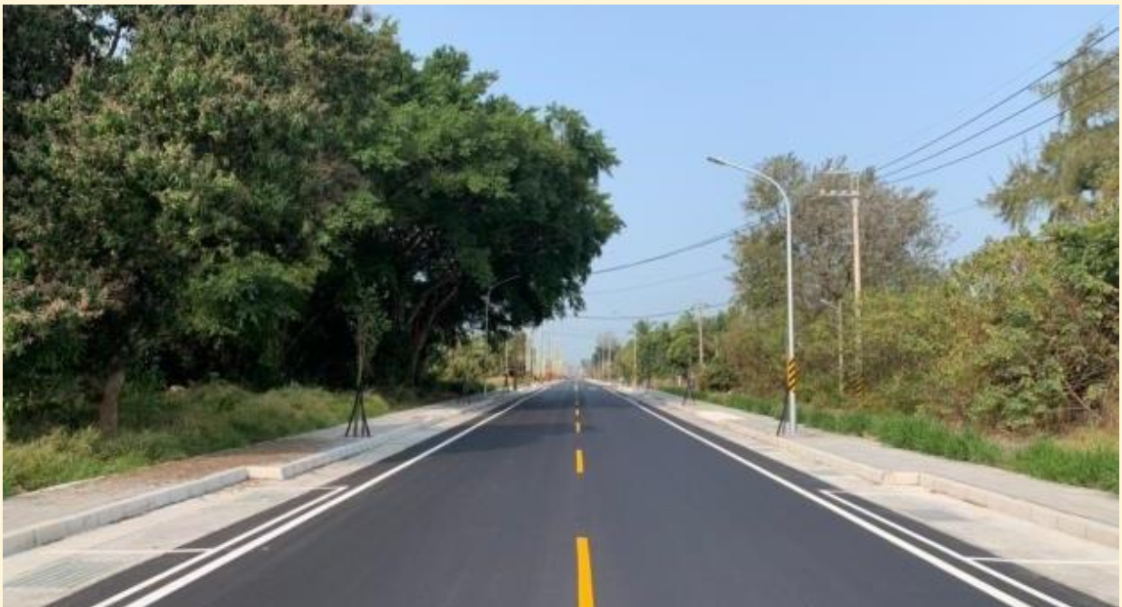
照片 2、完工照片
