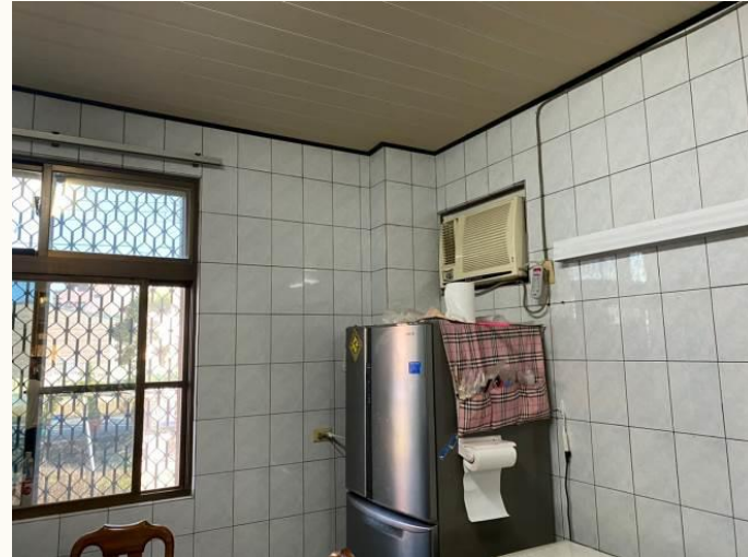
受損戶1樓 梁柱現況
