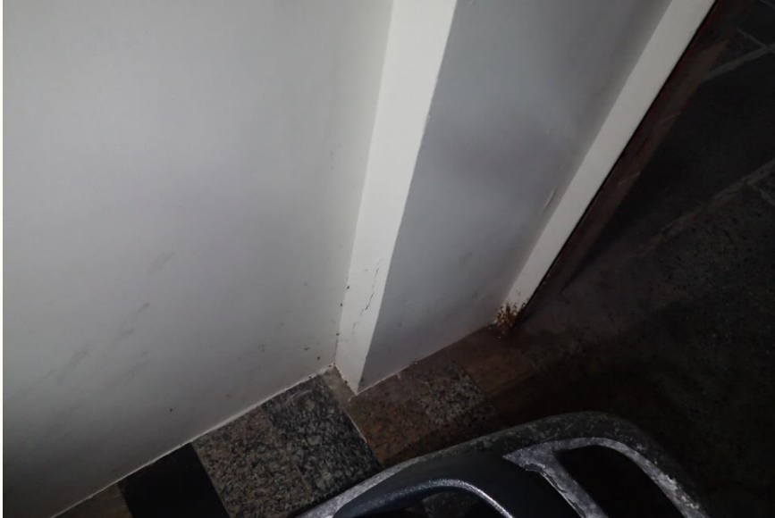
受損戶1樓 梁柱現況
