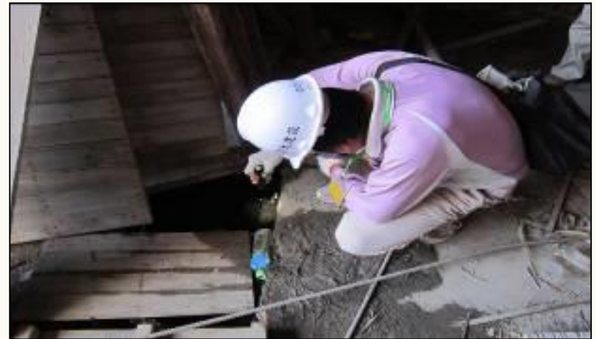
車道下方水溝
