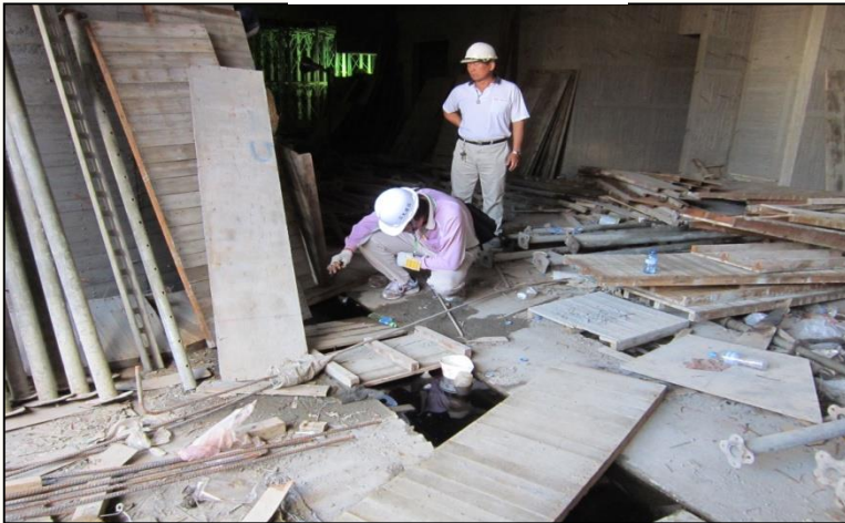
車道下方水溝
