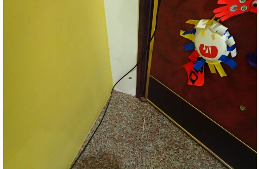
受損戶1樓 梁柱現況
