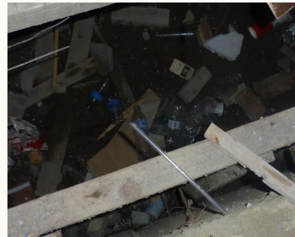
建築工地廢棄物堆積處
