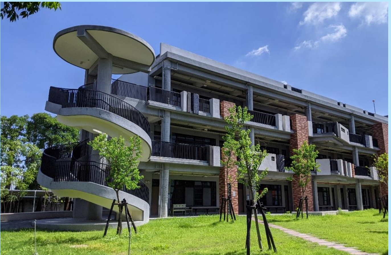
照片 1、新設圓梯與校舍一隅
