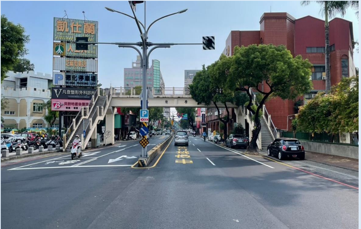
照片 2、東區長榮路完工照片
