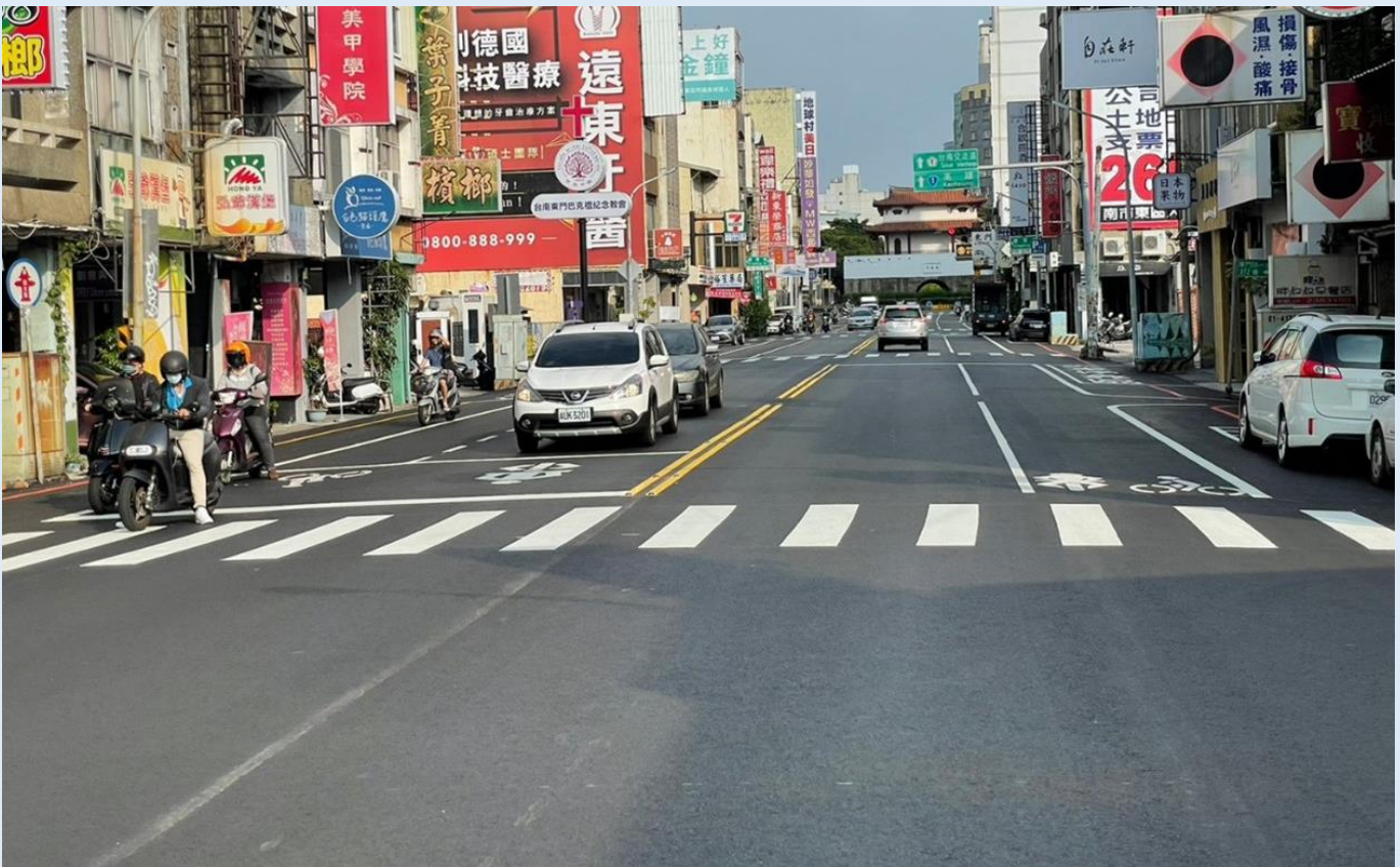
照片 1、東區東門路完工照片
