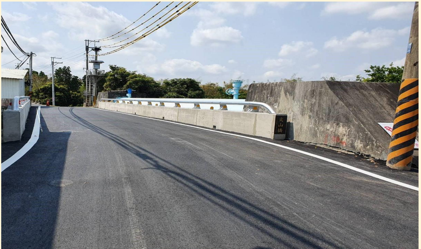
照片 3、完工照片
