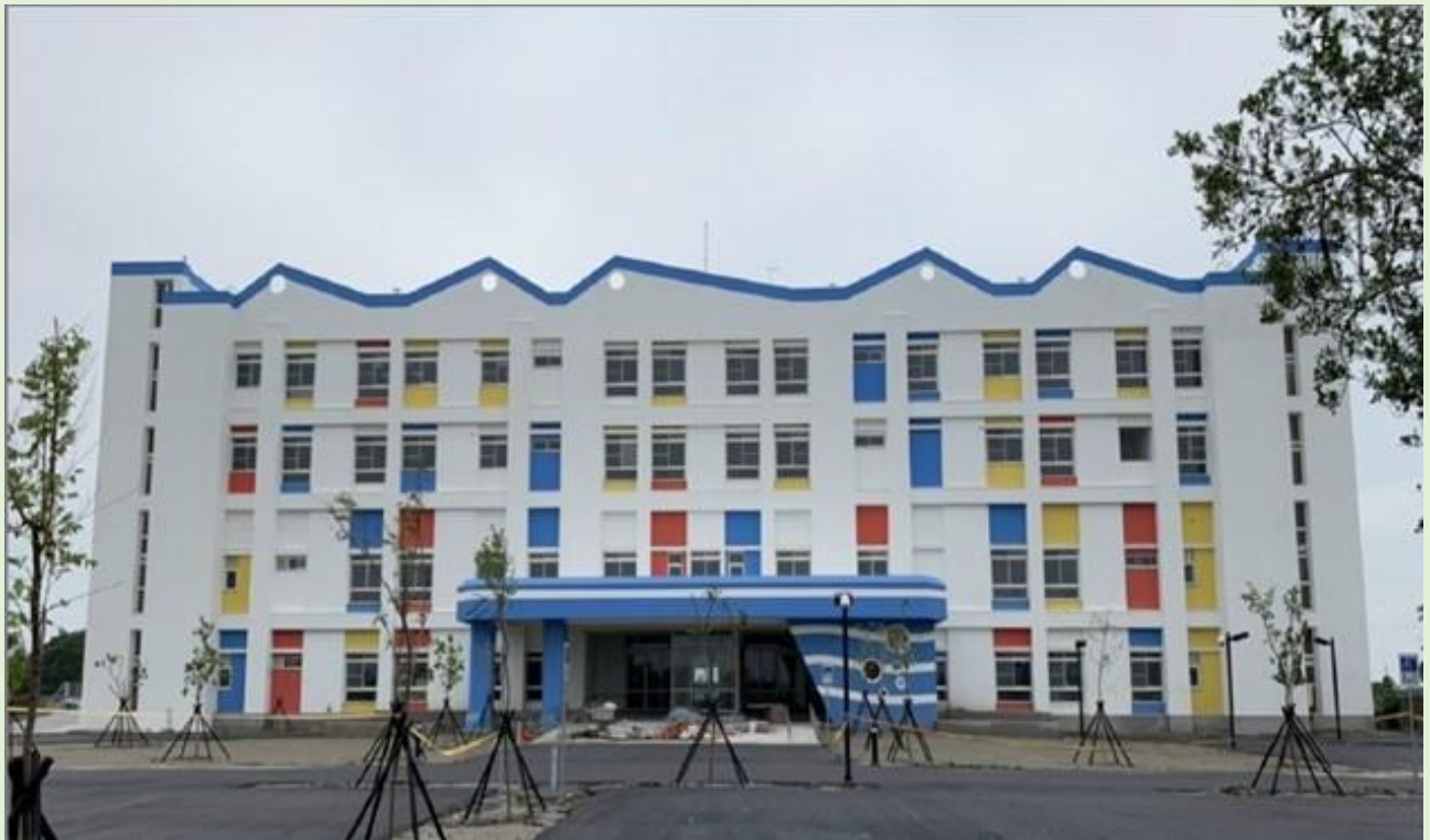
照片 2、完工正面照
