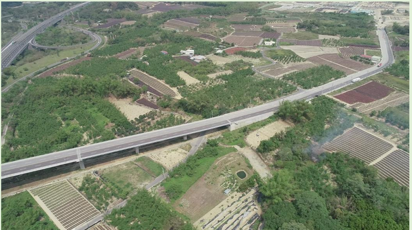
照片 2、施工前空拍全景-工程起點
