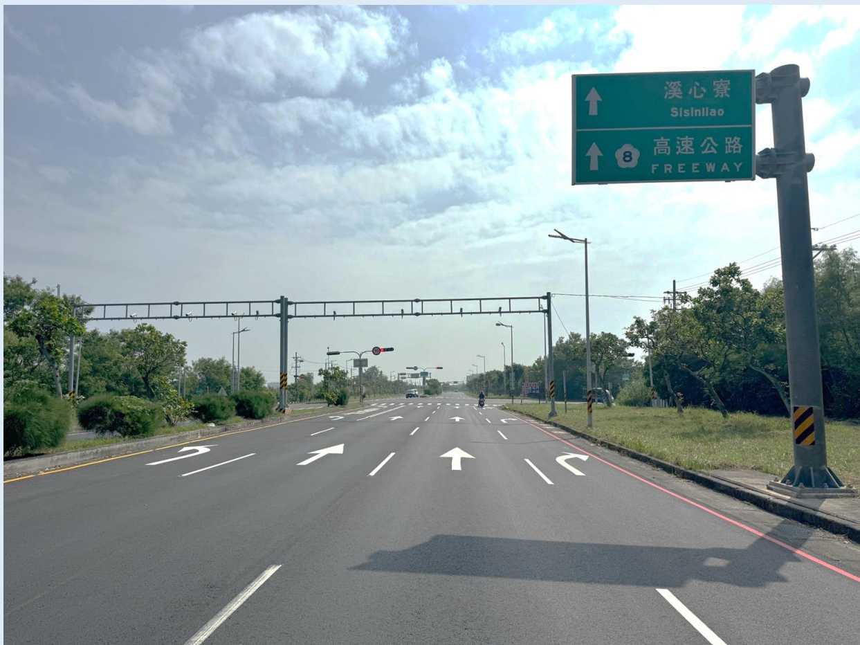
照片 1、完工後照片
