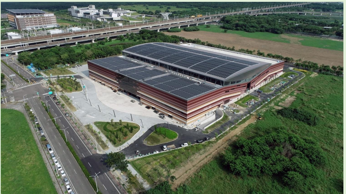
照片 2、西北向鳥瞰完工照
