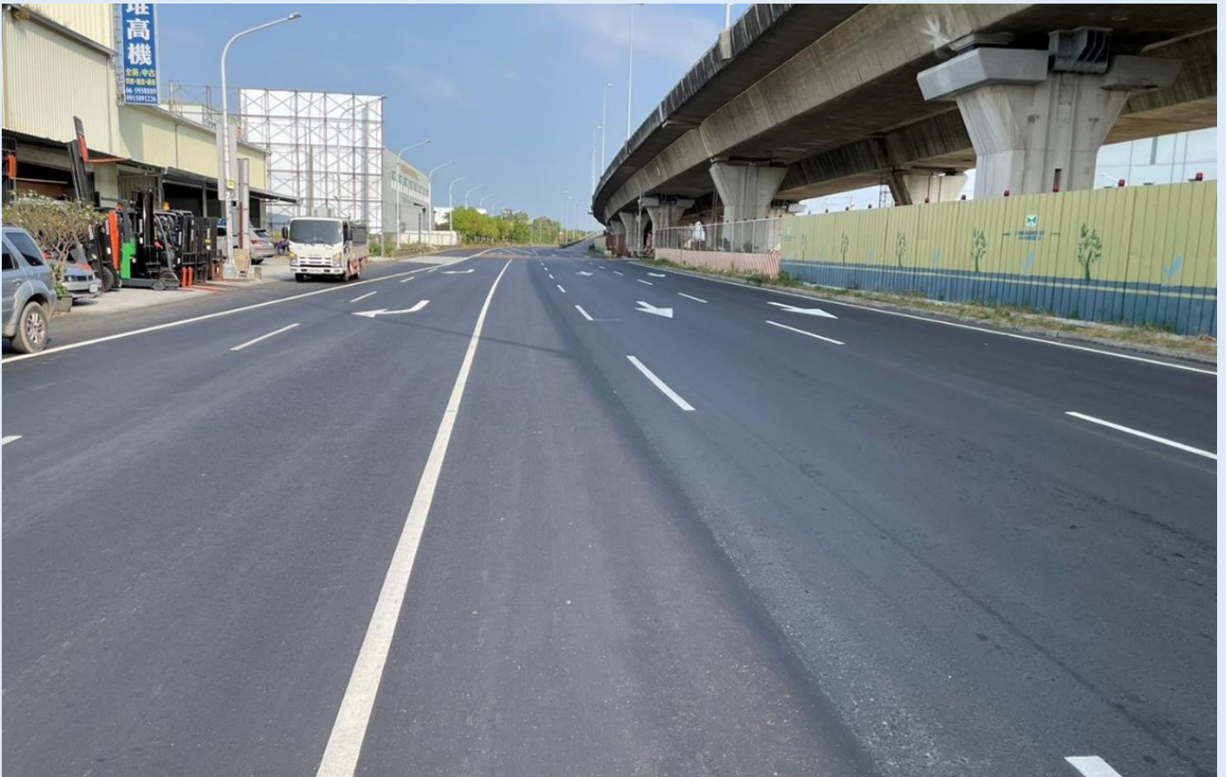
照片 2、完工照片
