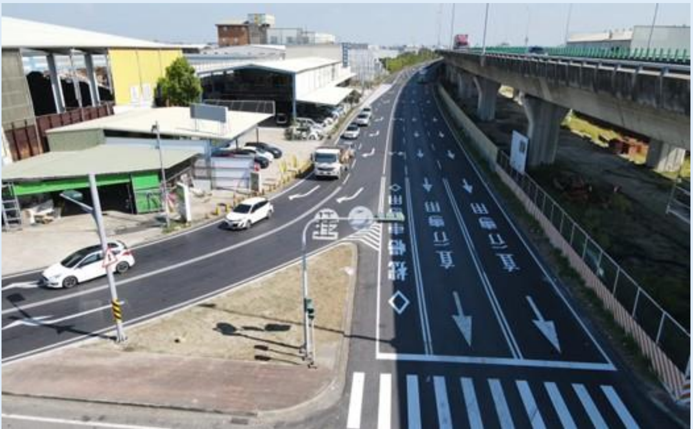
照片 1、完工照片
