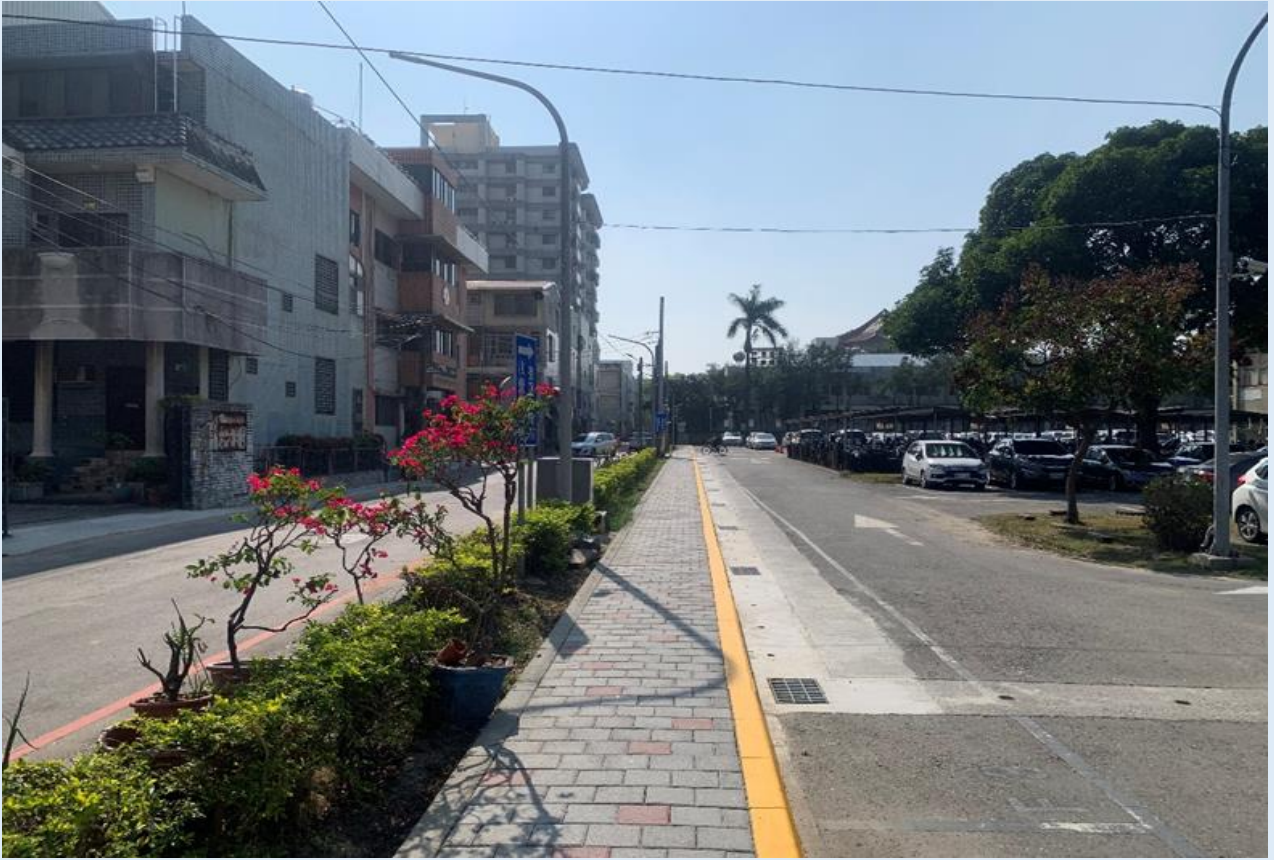
照片 2、完工照片
