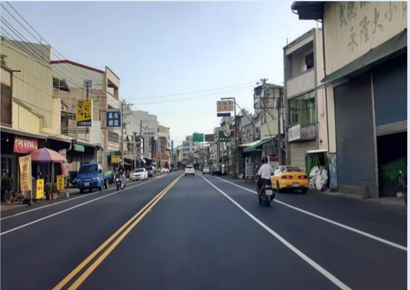
照片 1、安和路一段路面鋪設完成
