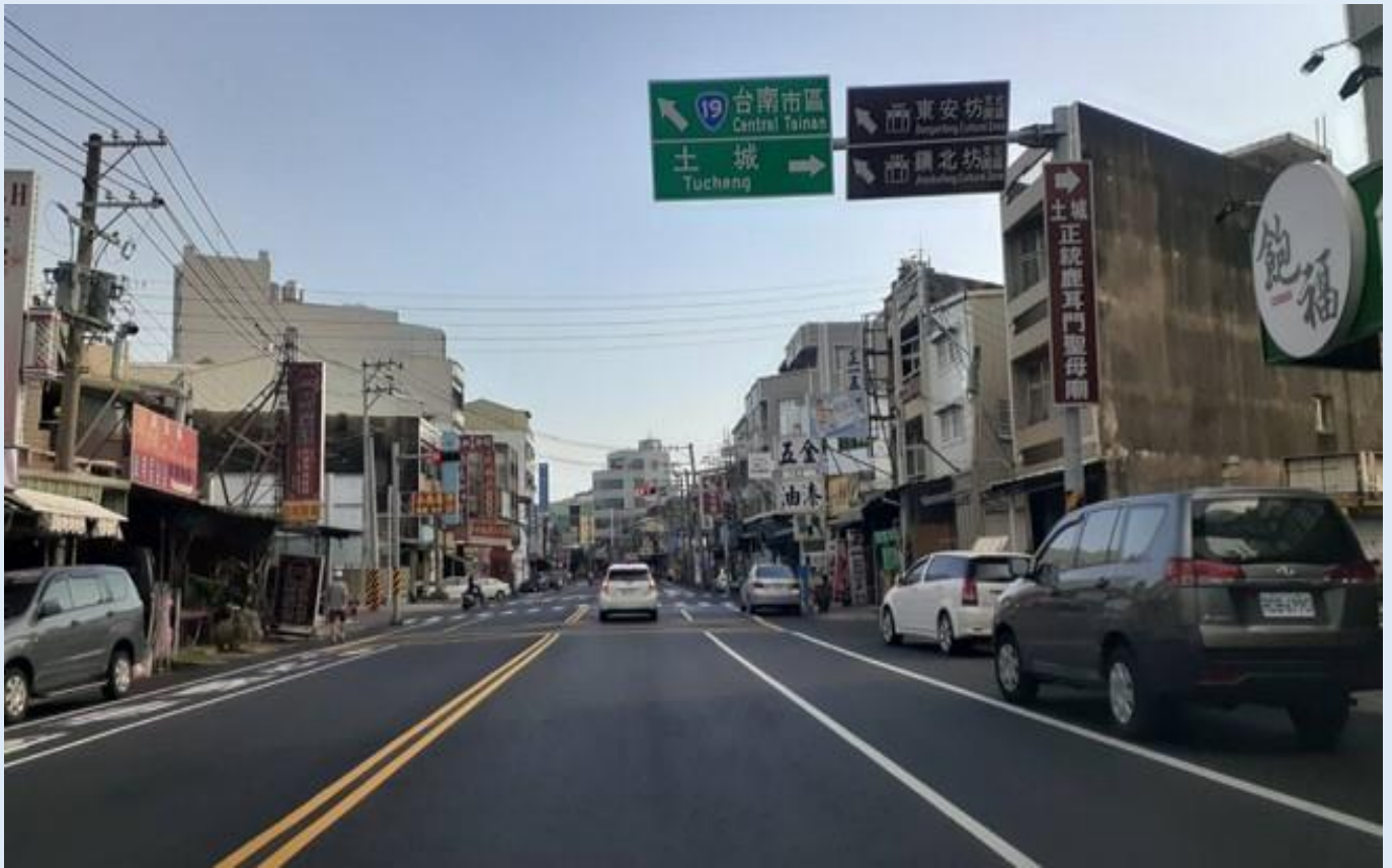
照片 2、安和路一段路面鋪設完成
