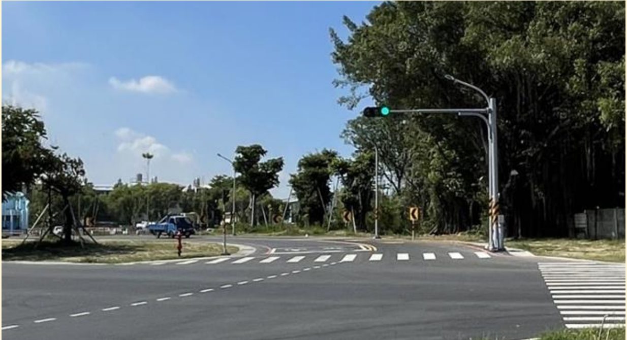
照片 2、完工照片(大林路與體育路口)
