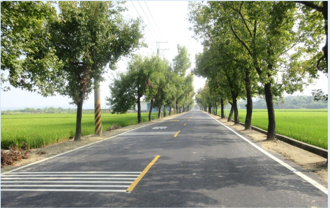
照片 1、路面改善、標線更新、綠帶整理
