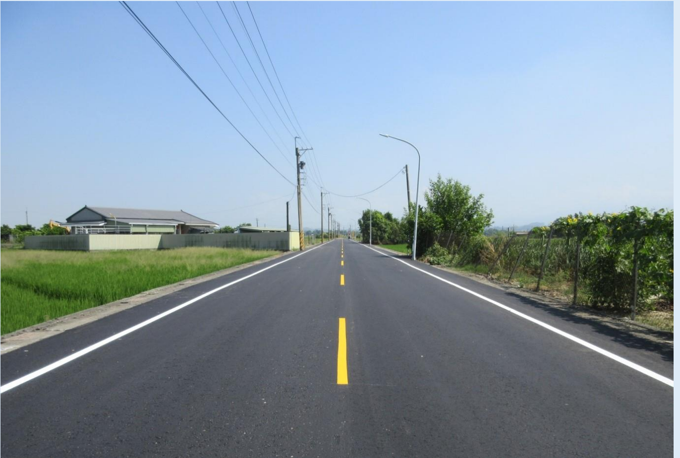
照片 2、路面改善及標線更新
