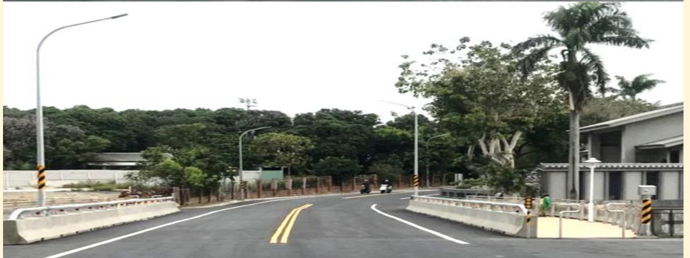
照片 3、施工前(上)後(下)
