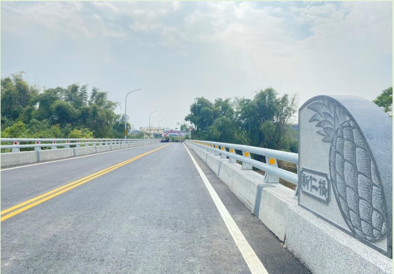
照片 2、新仁橋橋名柱
