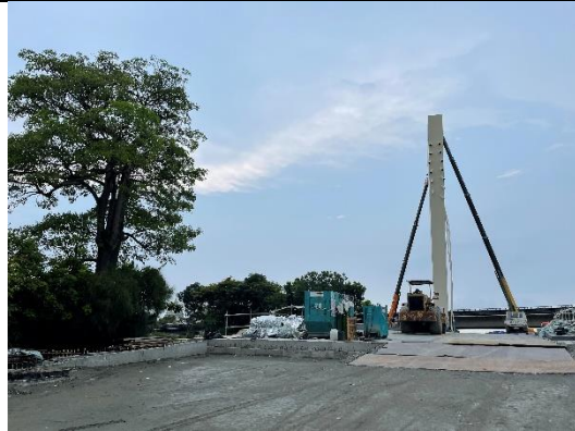
拍照日期：111 年 06 月 28 日 說明：新建橋體。
