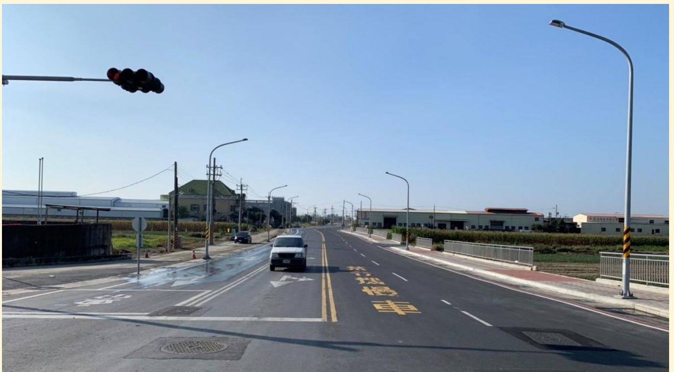
照片 3、完工照片(計畫道路與安吉路口處)
