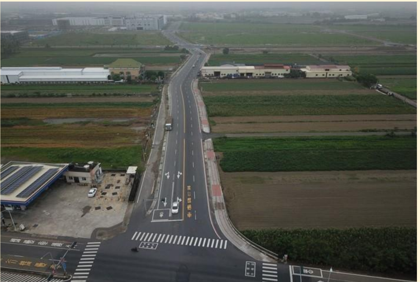
照片 1、完工全景空拍圖
