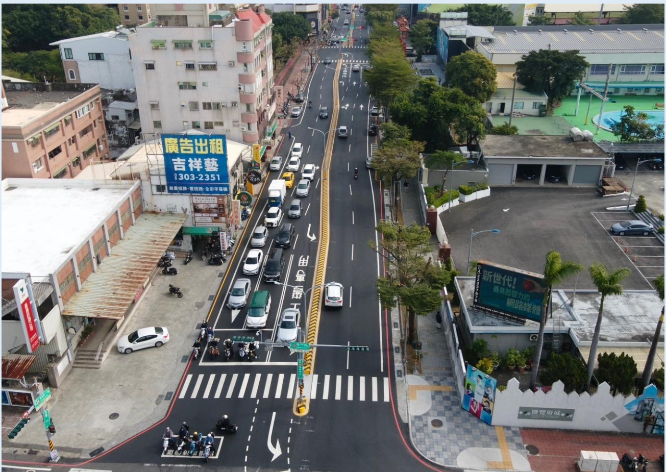
照片 1、完工照片(與南門路交叉路口)
