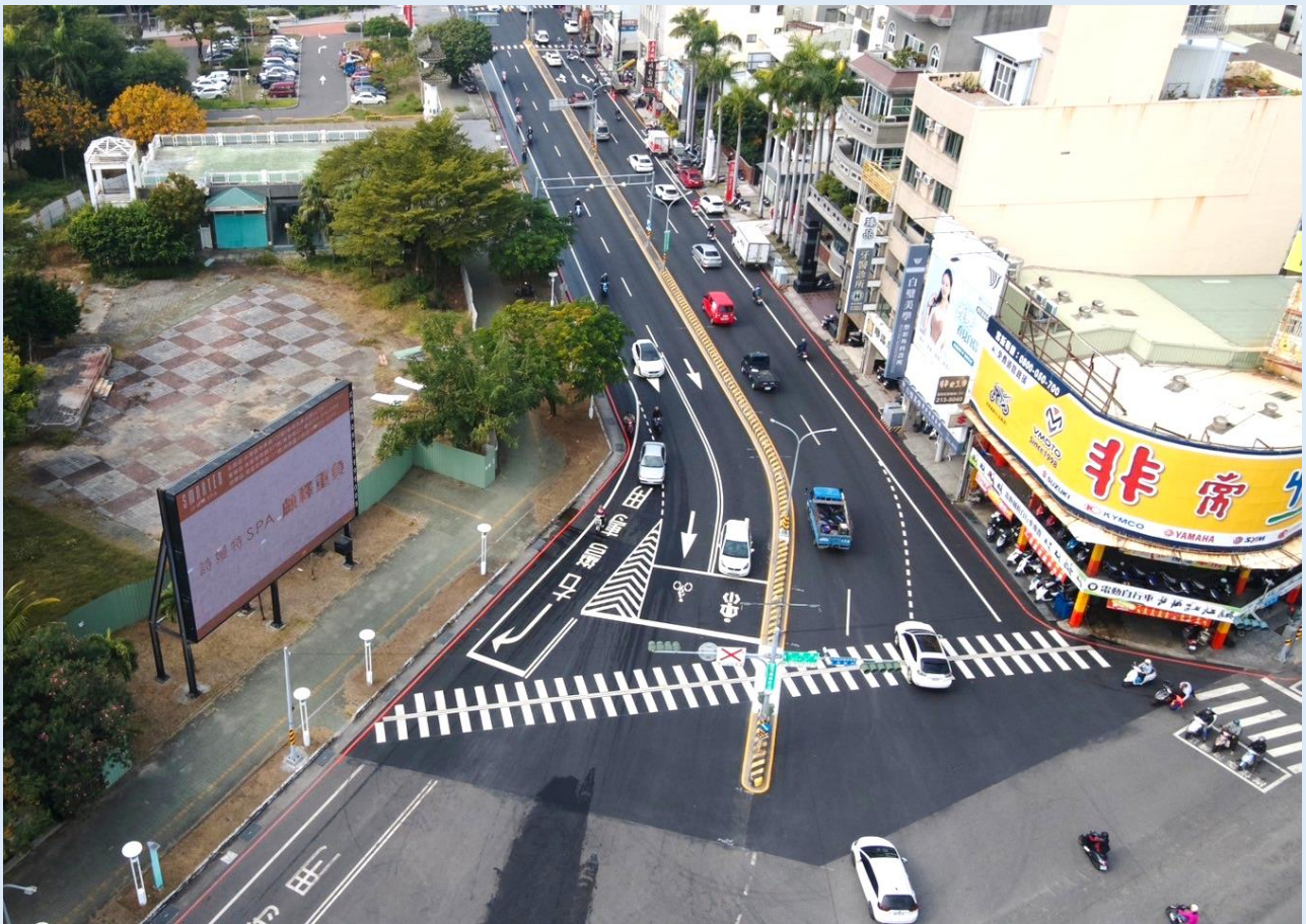
照片 2、完工照片(與大同路交叉路口)
