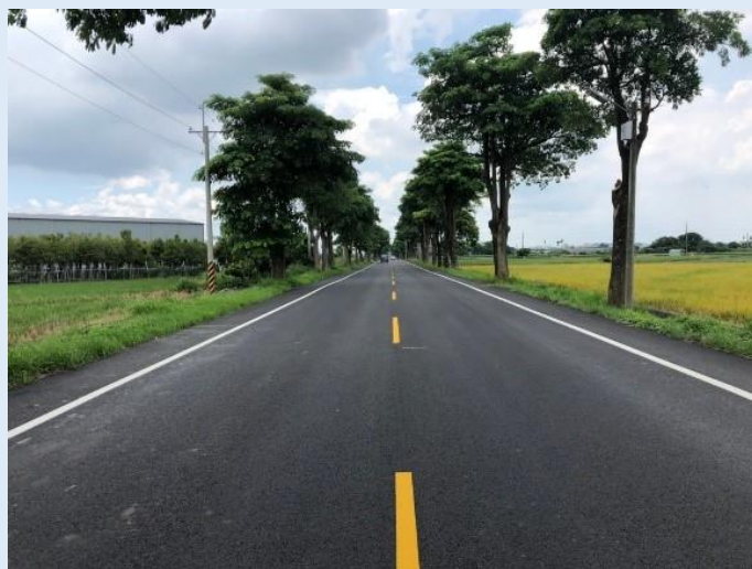
照片 4、南 129 線完工
