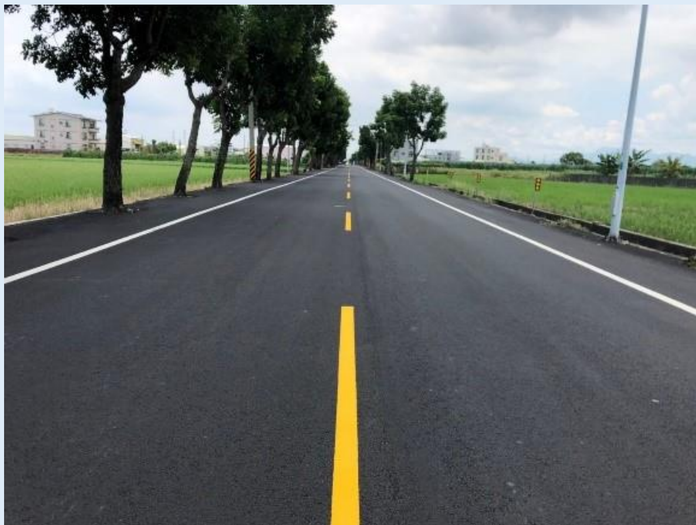
照片 5、南 127 線完工
