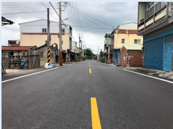
照片 3、南 122 線完工
