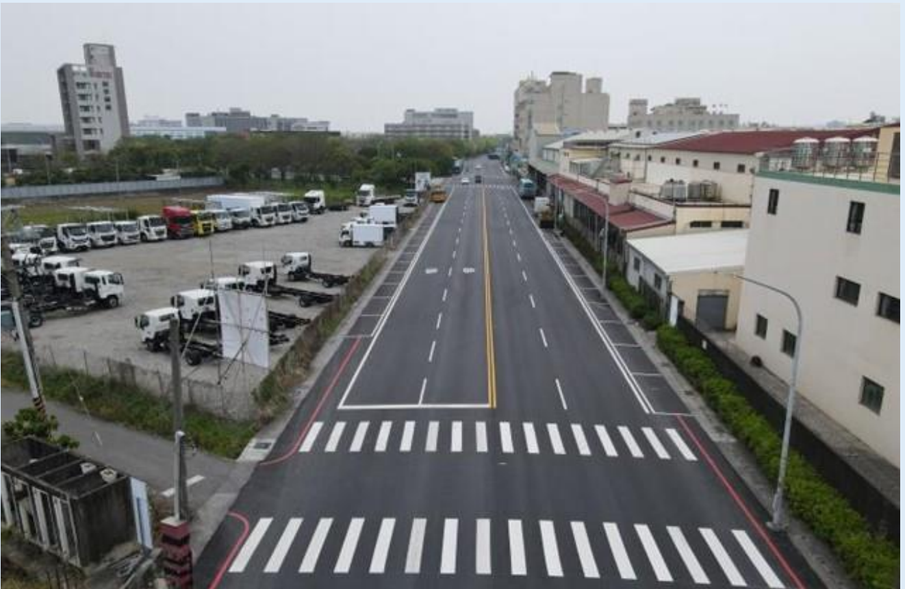
照片 1、完工照片
