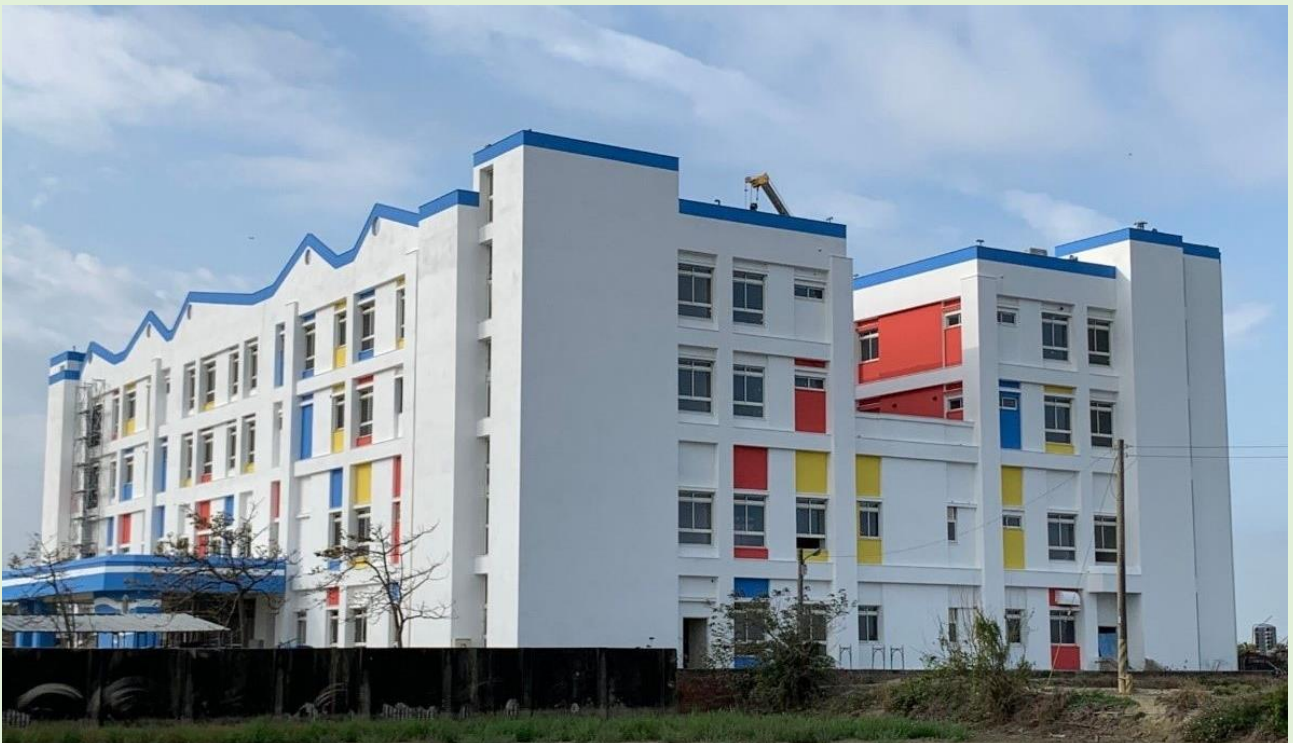
照片 2、完工照片
