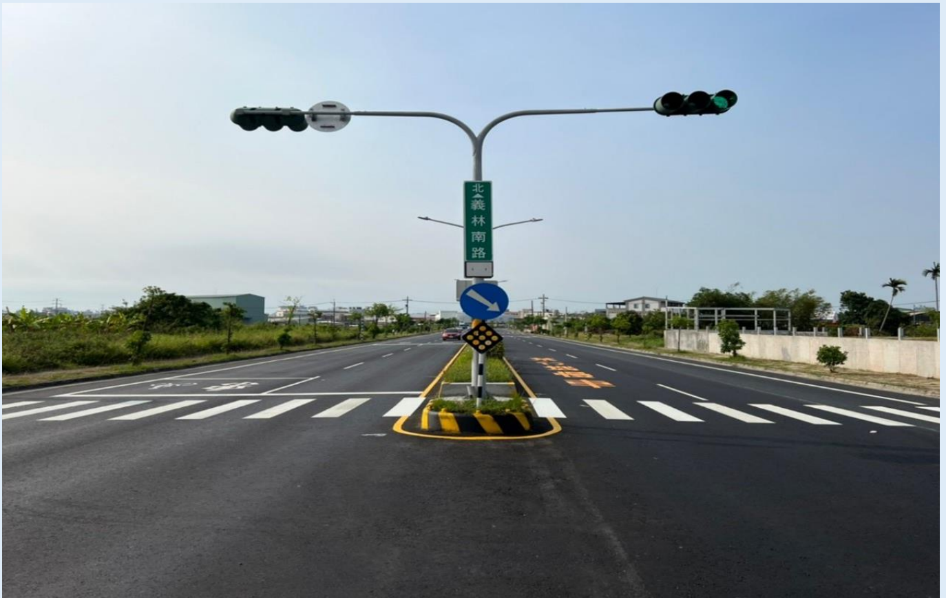
照片 2、完工照片
