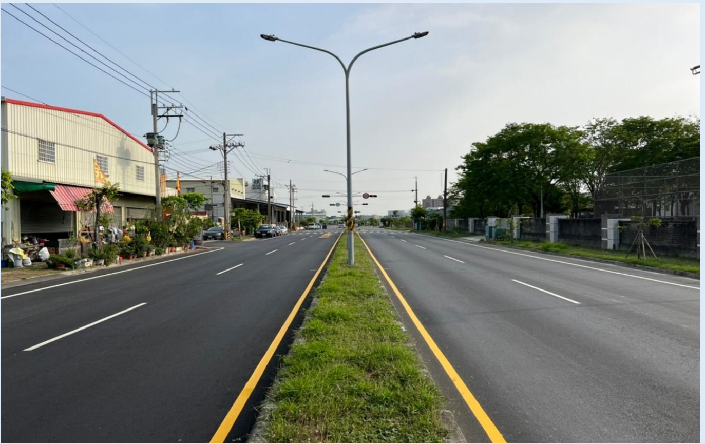
照片 1、完工照片
