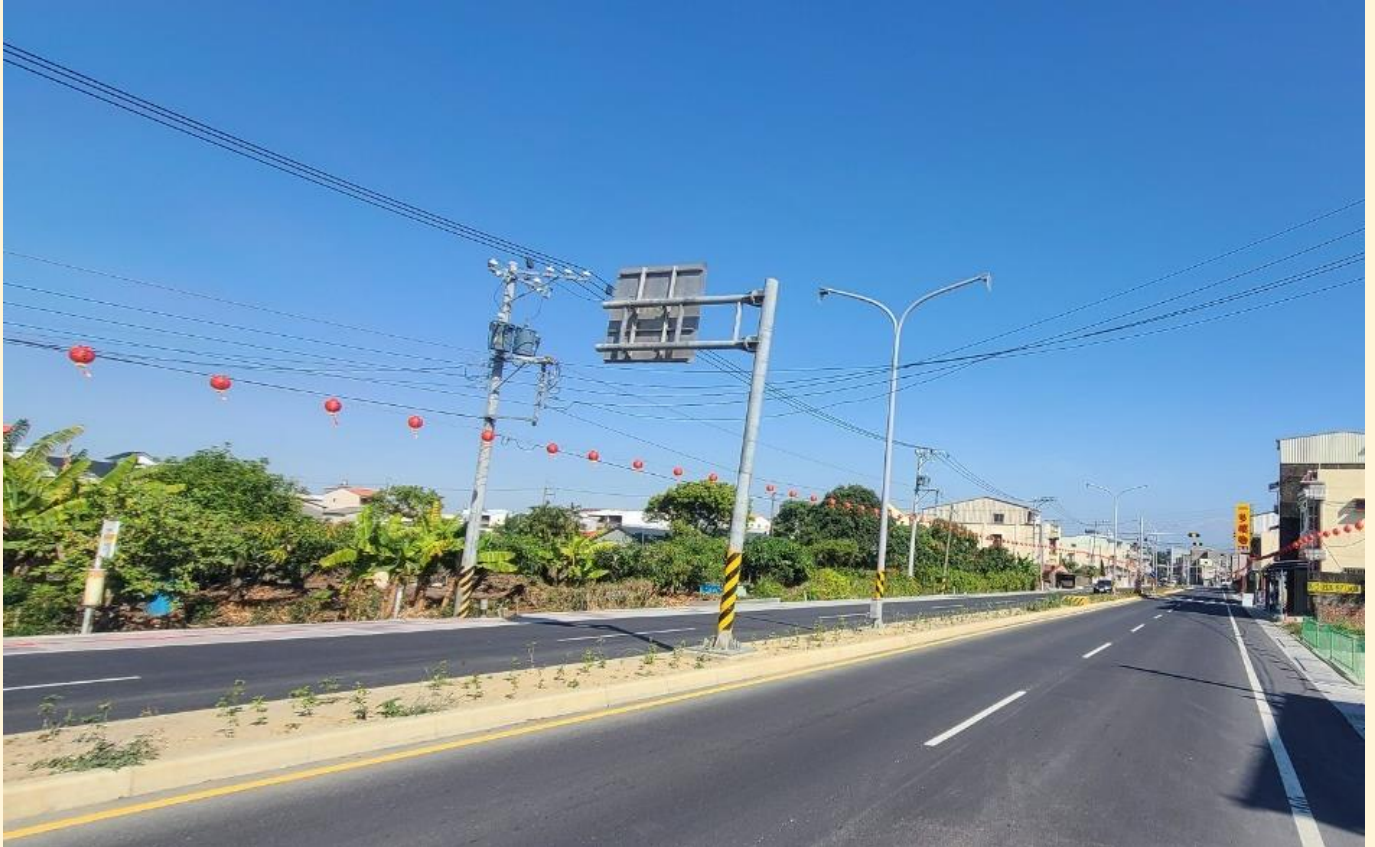
照片 2、完工照片
