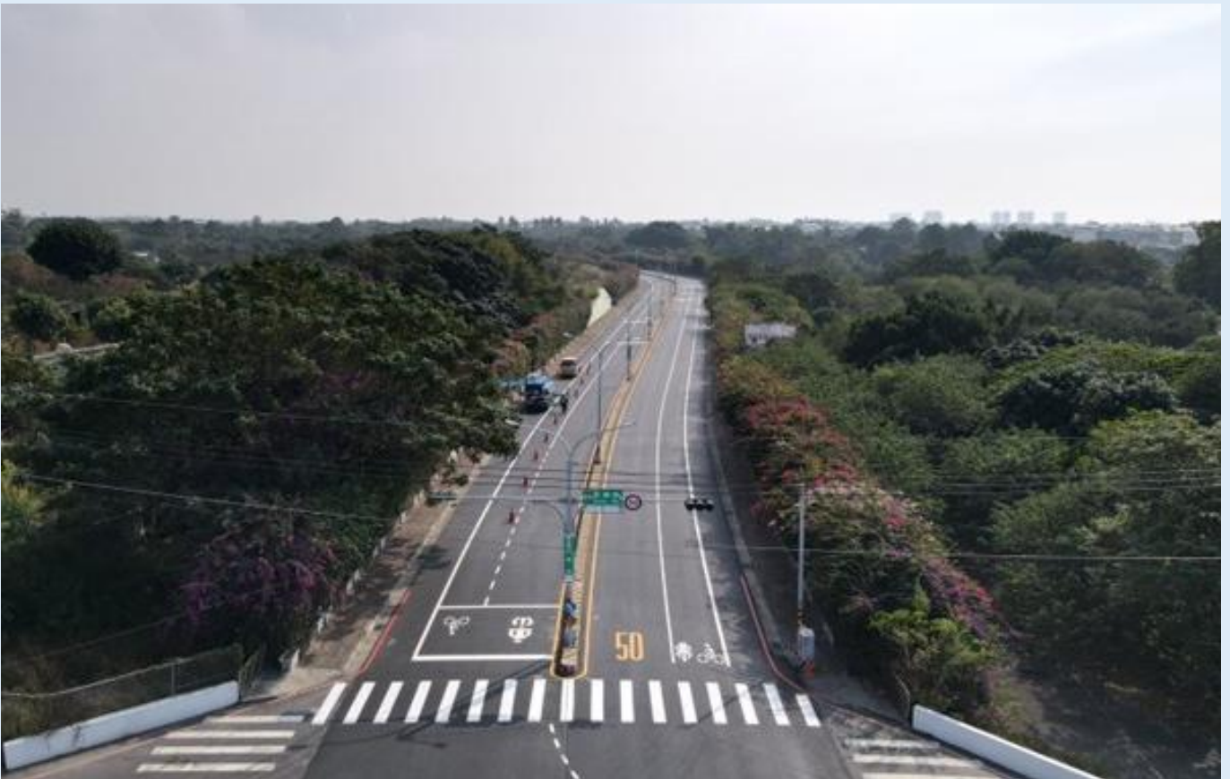
照片 2、新都路與西門路口完工照片
