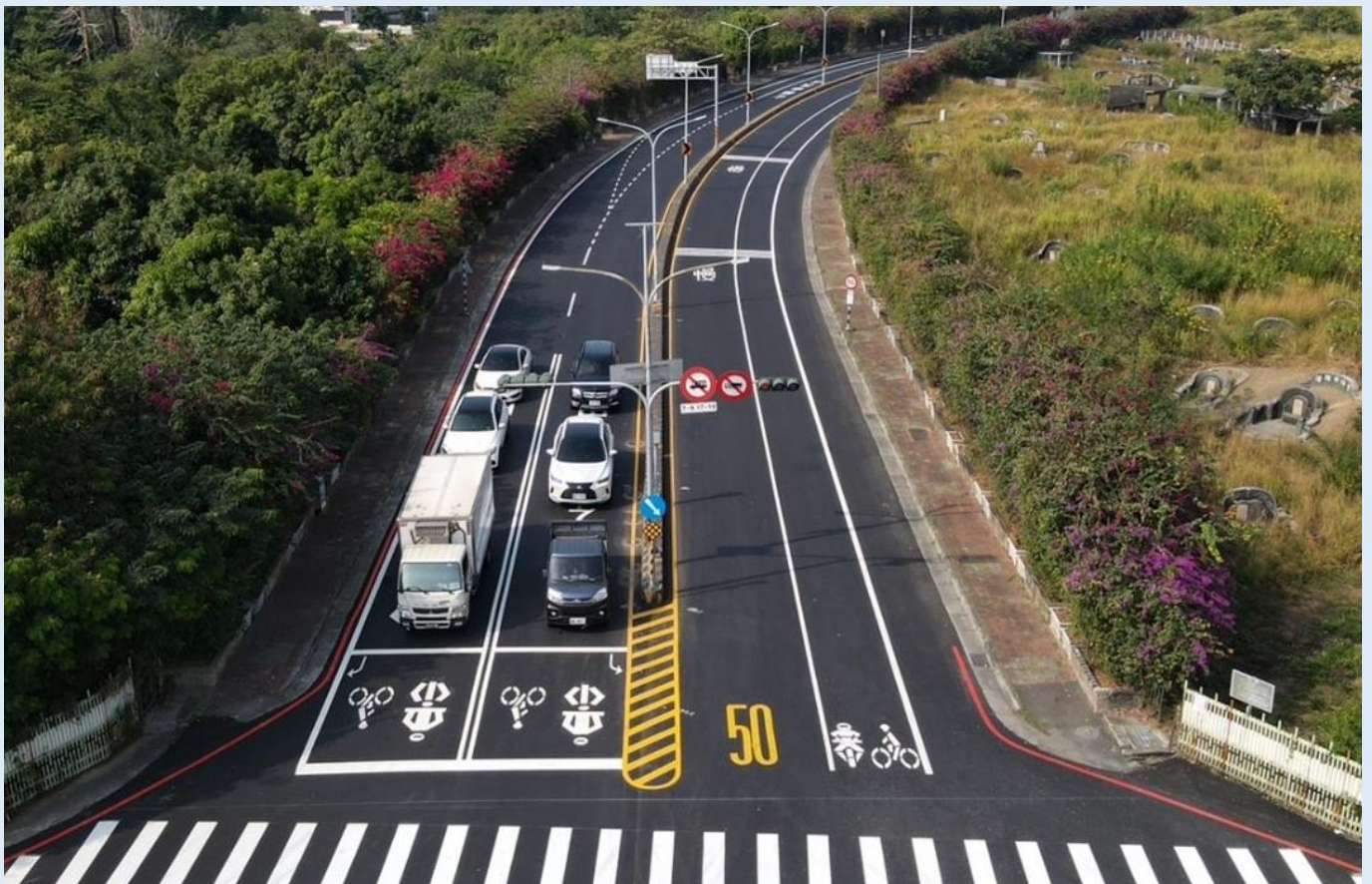
照片 1、中華南路與西門路口完工照片
