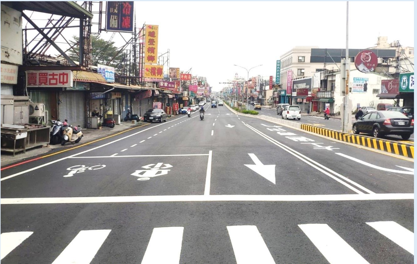
照片 2、完工照片
