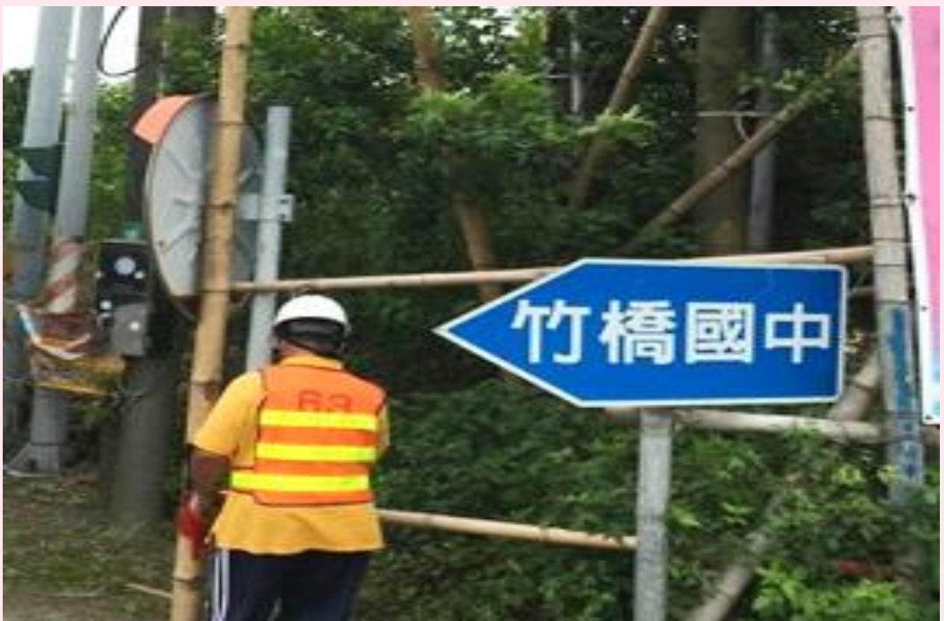
照片 2、手持鋸鏈拆除違規廣告
