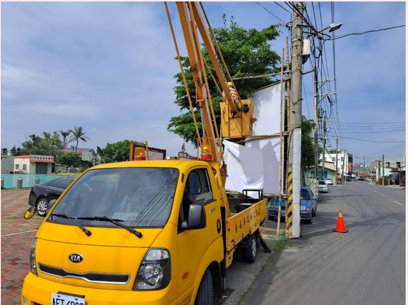
照片 1、高空作業車拆除違規廣告
