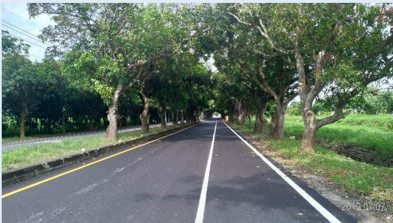
照片 3、部分路段完工(施工後)
