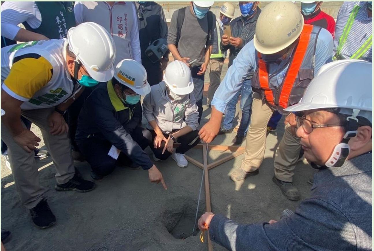
照片 1、實際鑿洞測量瞭解表層結構
