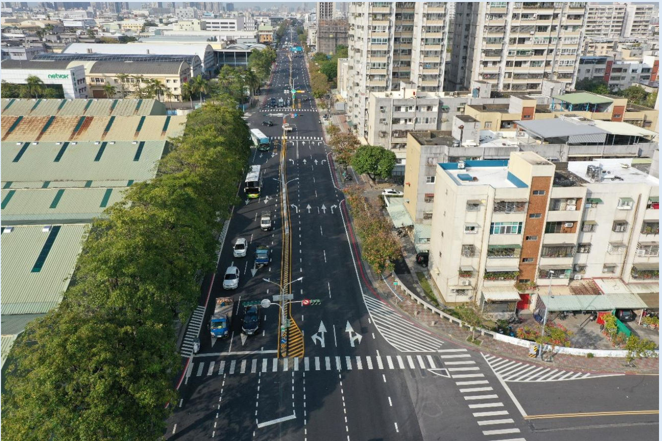
照片 2、完工照片(新平路口)
