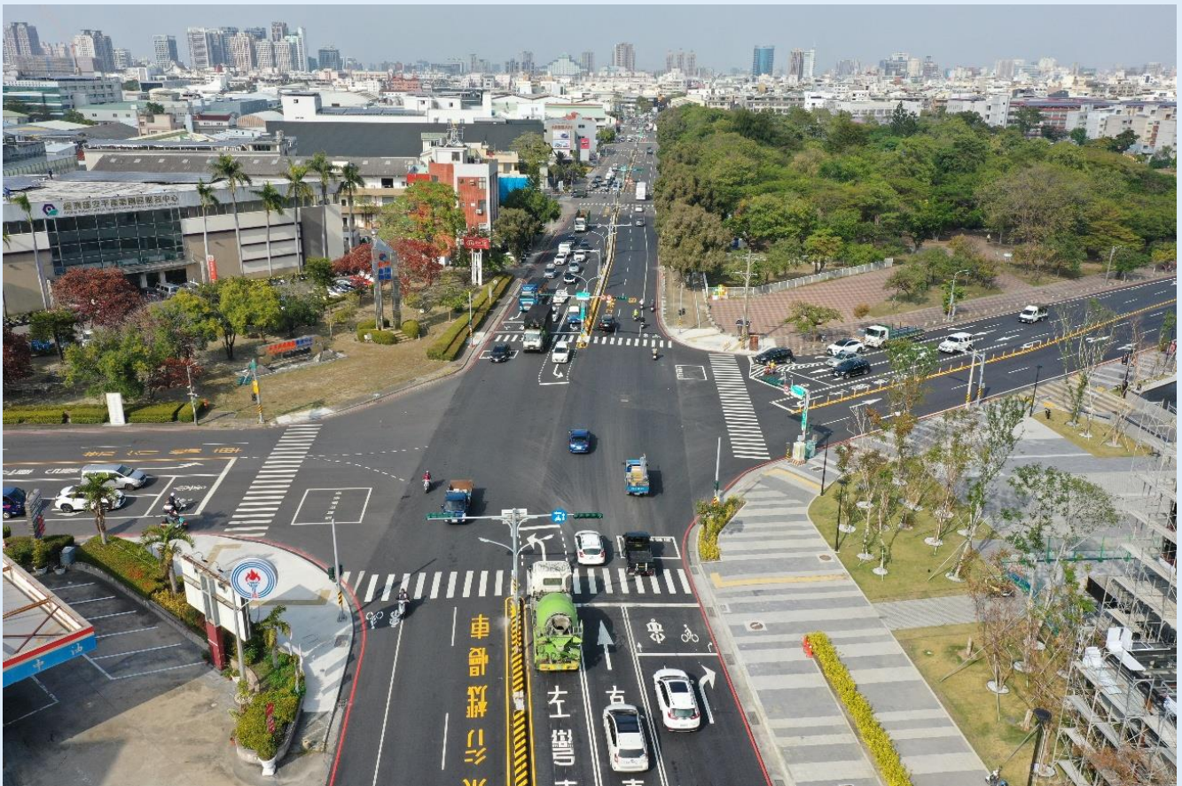
照片 1、完工照片(新興路口)
