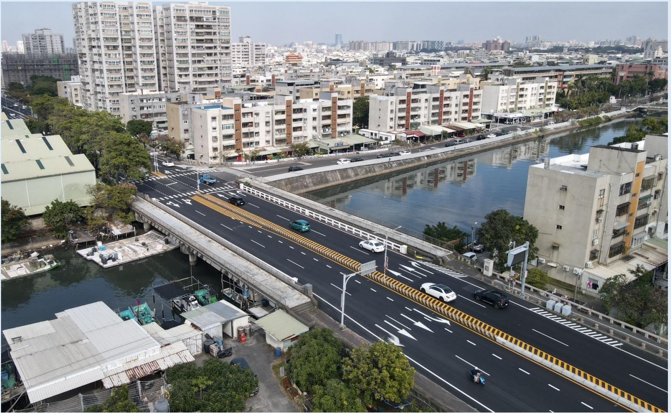
照片 3、完工照片
