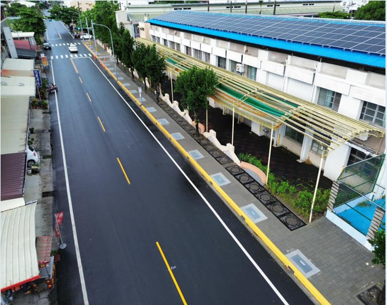
照片 3、東原國小通學道改善及南 104 線道路鋪面更新
