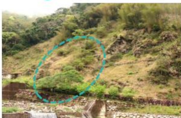
治理前- 坡面治理時保留 部分樹木殘根， 提供良好種原
