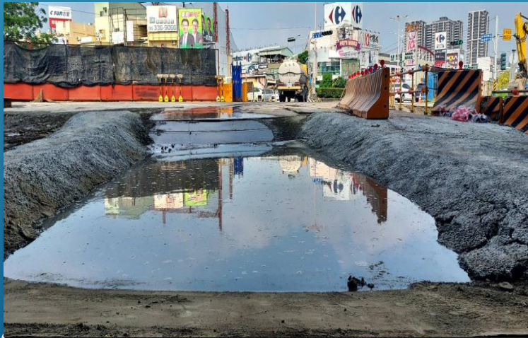
簡易洗車池設置
