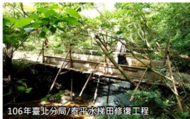
搭建臨時便橋 維持溪流 自然樣貌
