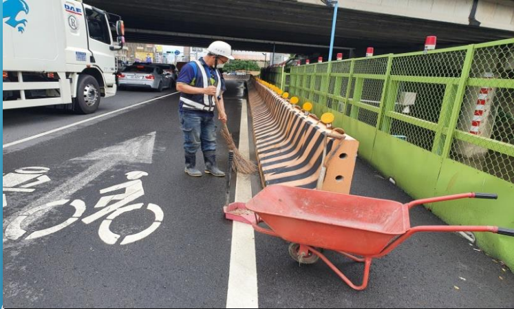
工區周邊環境整理
