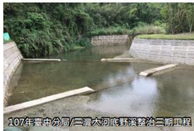
無落差固床工
