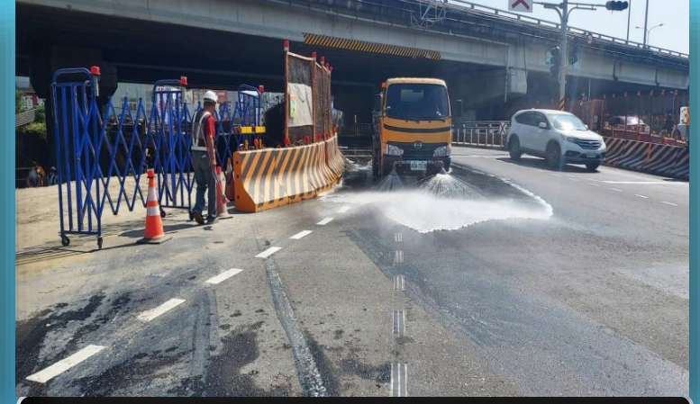
施工中道路清潔維護
