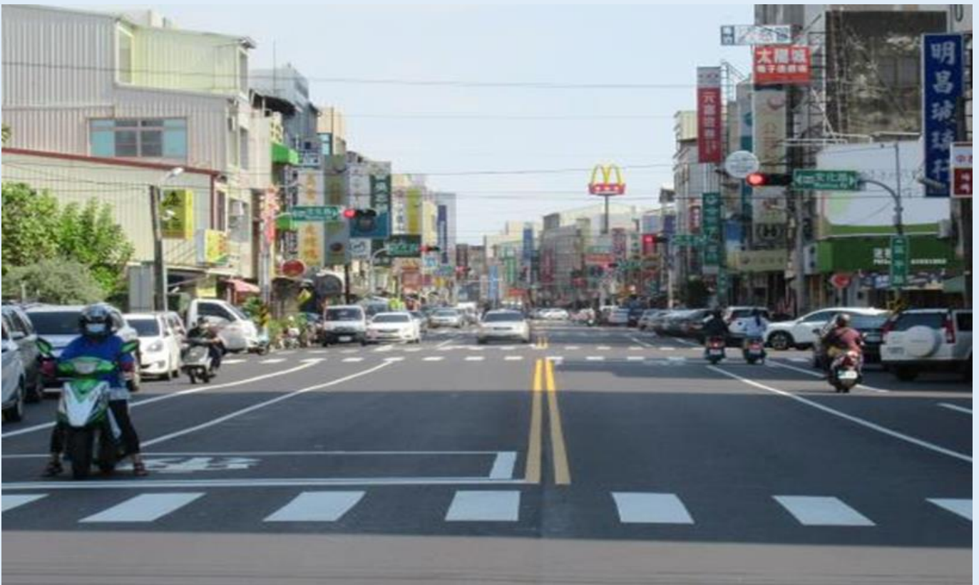
照片 1、延平路完工照
