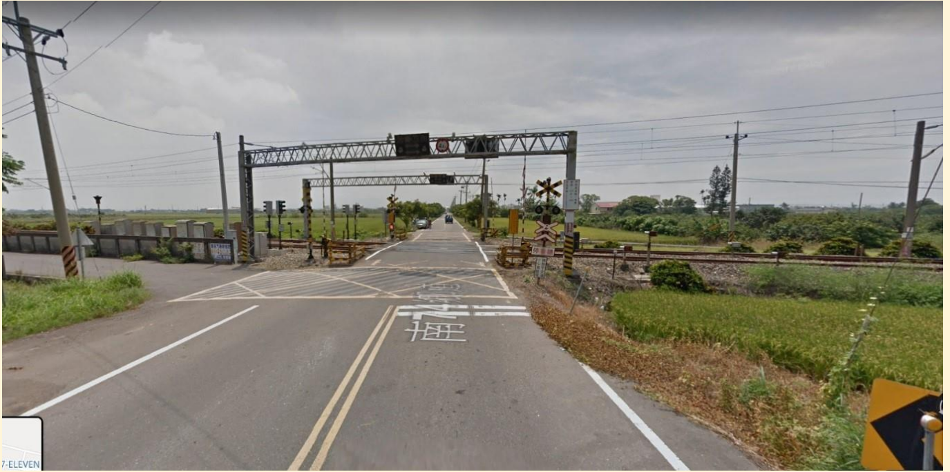
照片 2、台鐵埤寮平交道拓寬前
