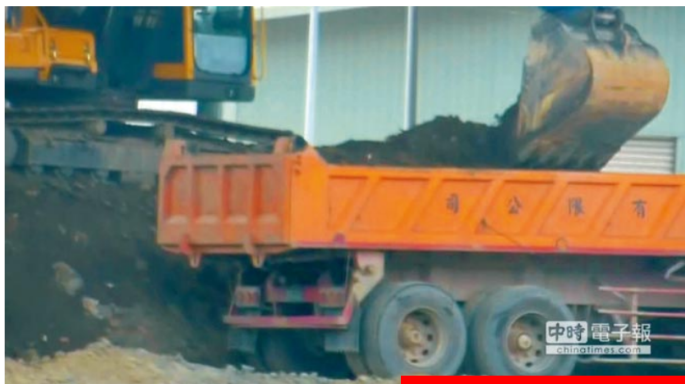
北市水利處與捷運工程局工程廢棄土遭土方清運公司提供)
