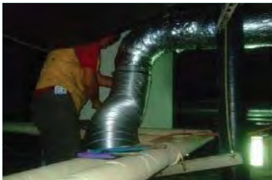
定期風管檢查
