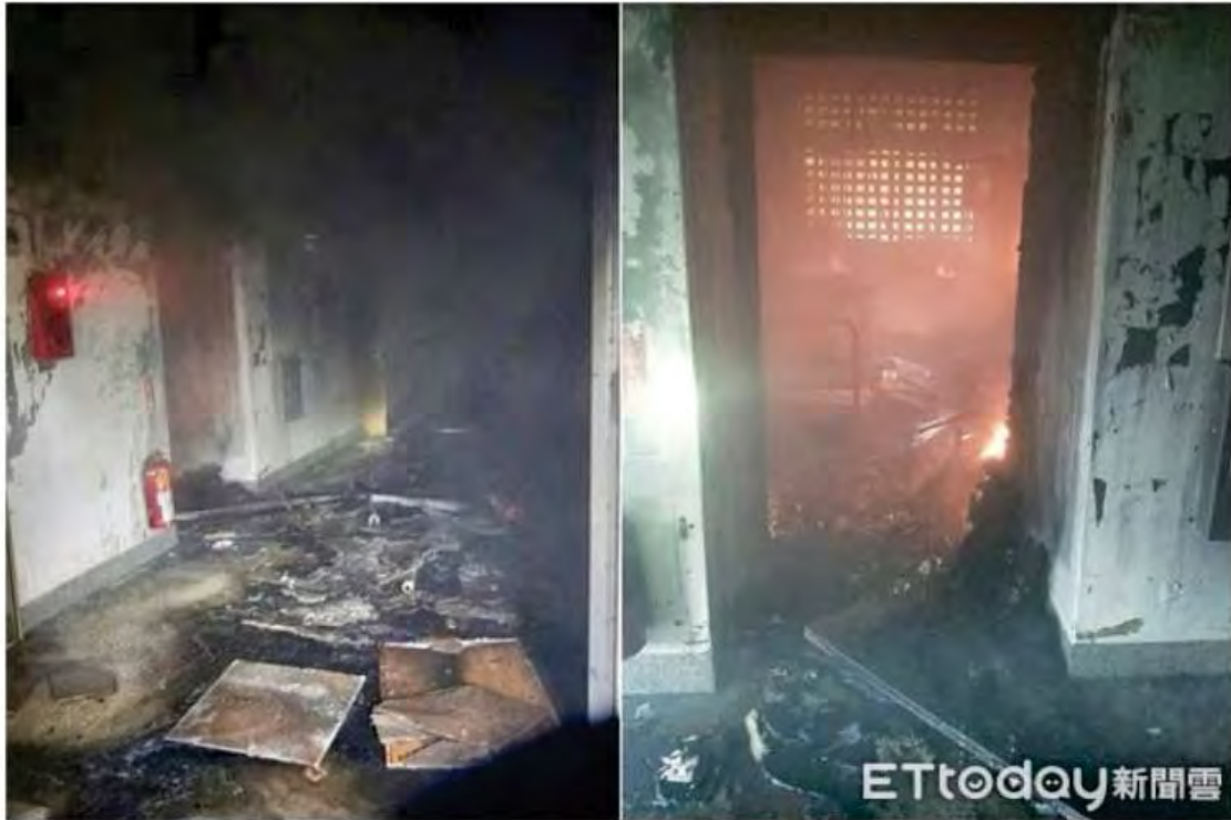
▲科大人文大樓10樓實驗室發生火警。(圖 / 記者莊智勝翻攝)
