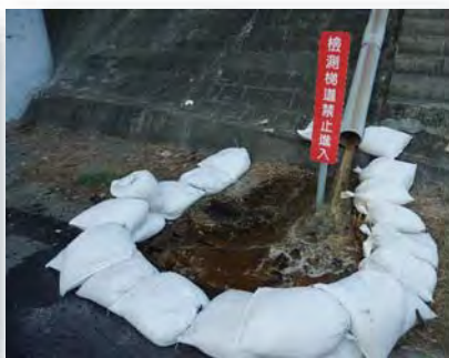
路面沖洗廢水阻遏、導流
