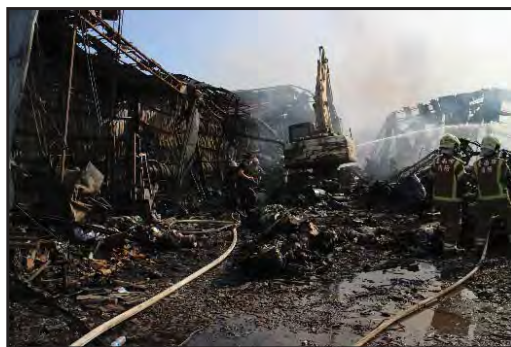
挖土機進行現場開挖
