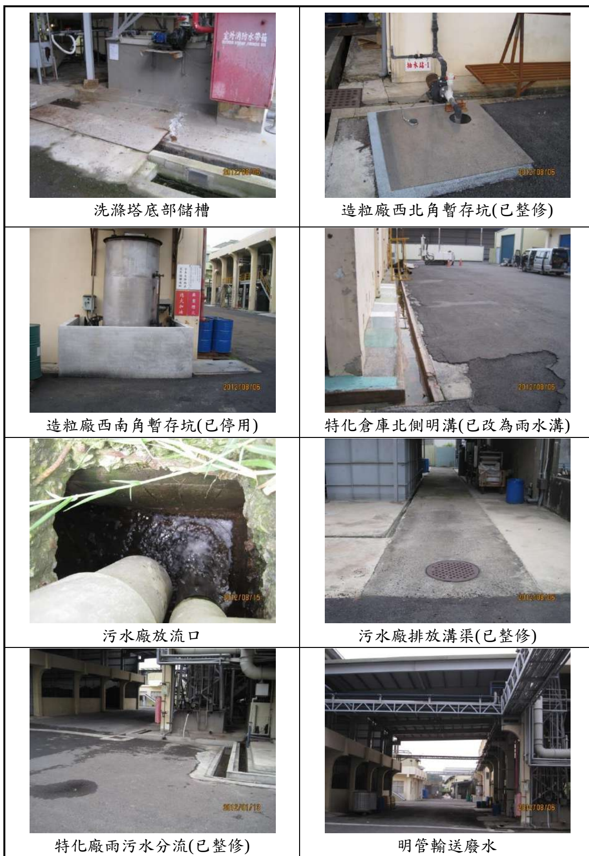
圖 3.3-7 場址污染來源與整修情形
