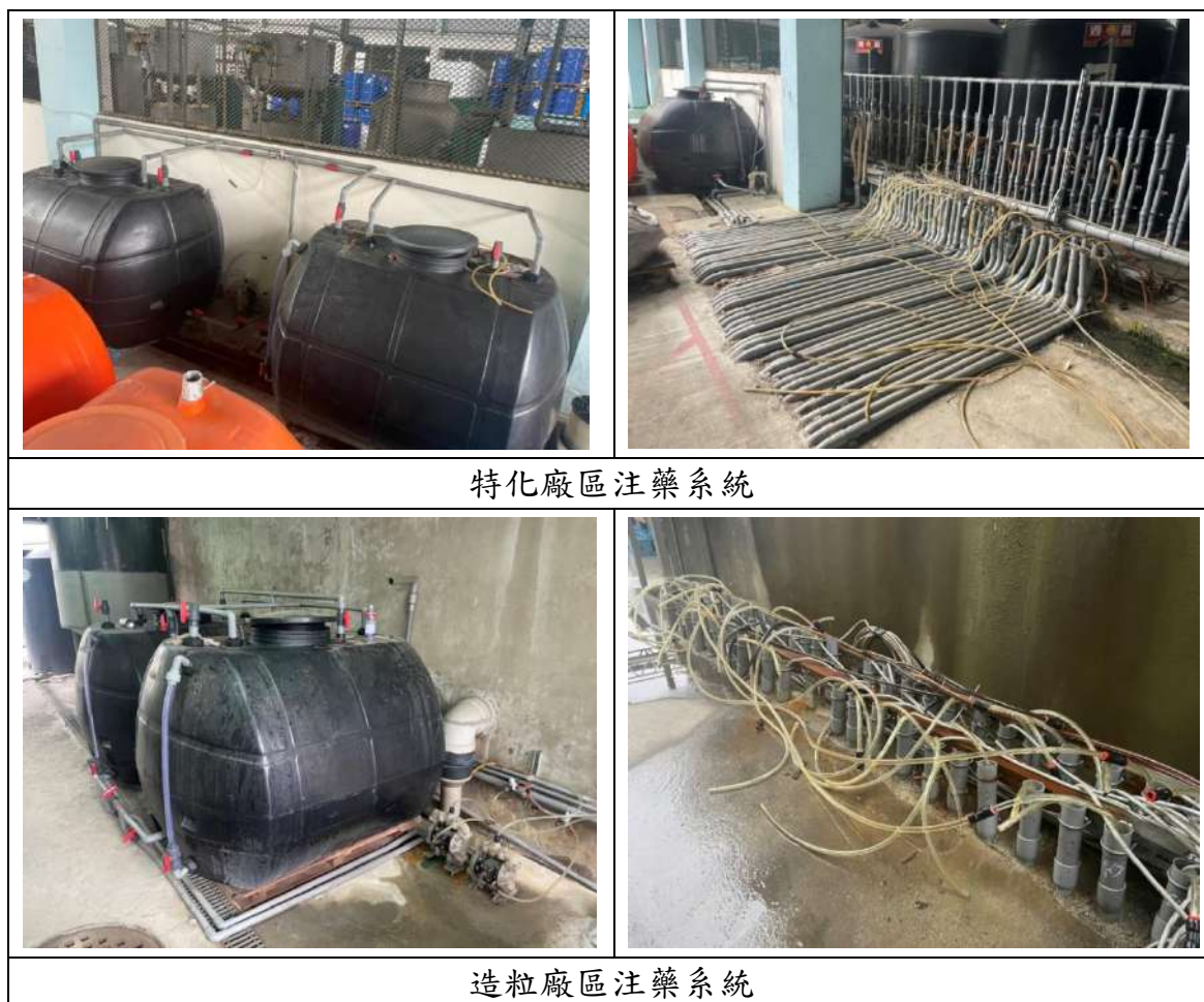
圖 7.2-9 化學氧化注藥系統現場照片
