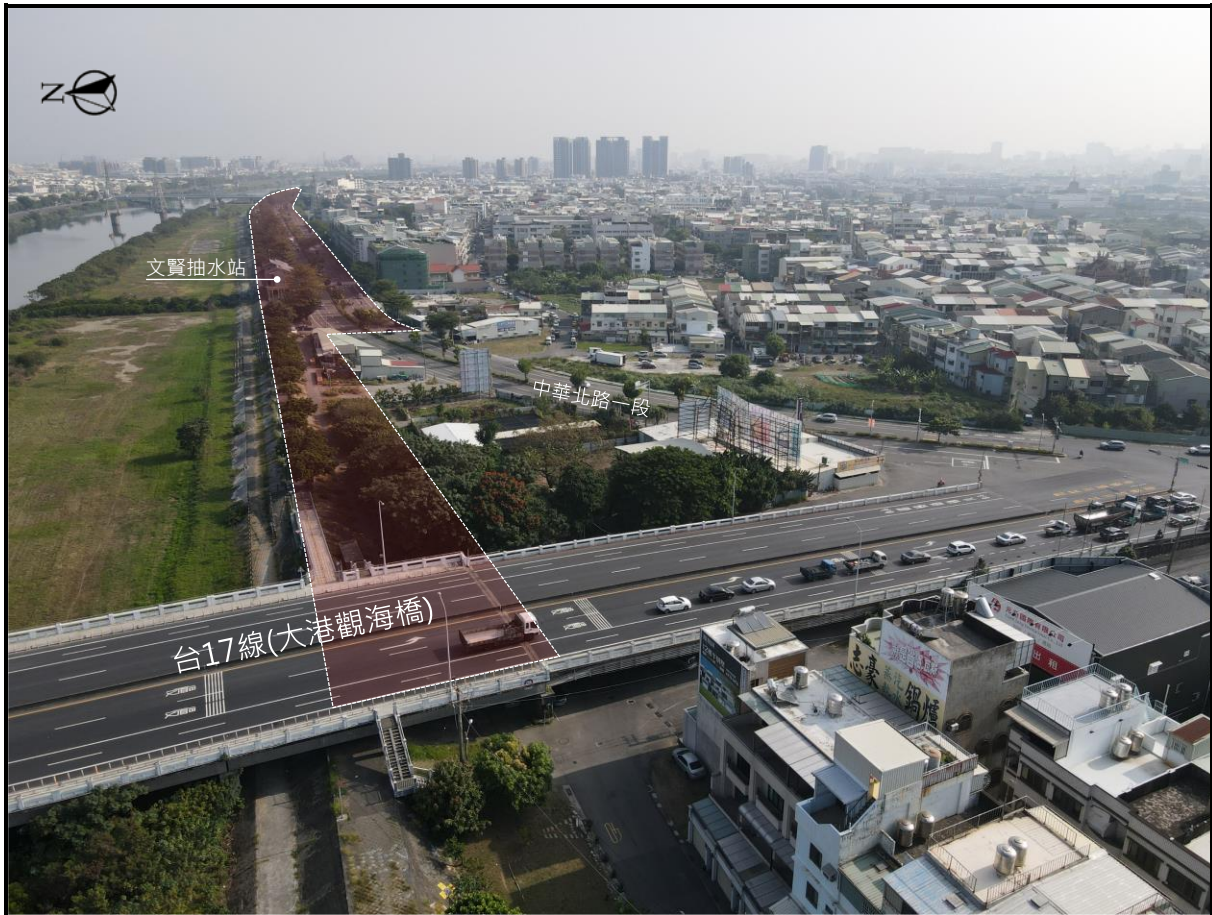
圖 9：臺 17 線(大港觀海橋)至臺 17 甲線(海佃路)現況照
