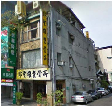
背（側）向立面照片
