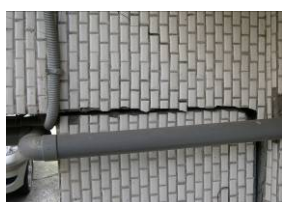
外牆柱斷裂
