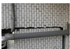
外牆柱斷裂
