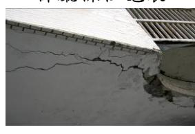
外牆鋼筋外露
