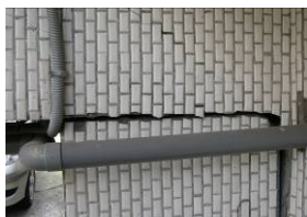
外牆柱斷裂
