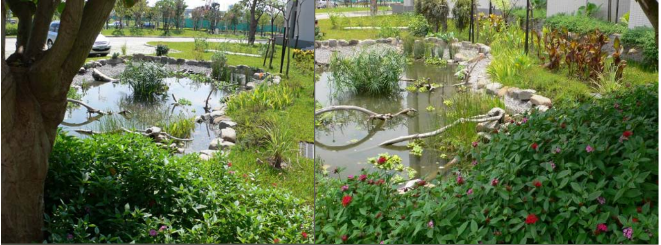
台達電子南科綠色廠房辦公室 生態水池
