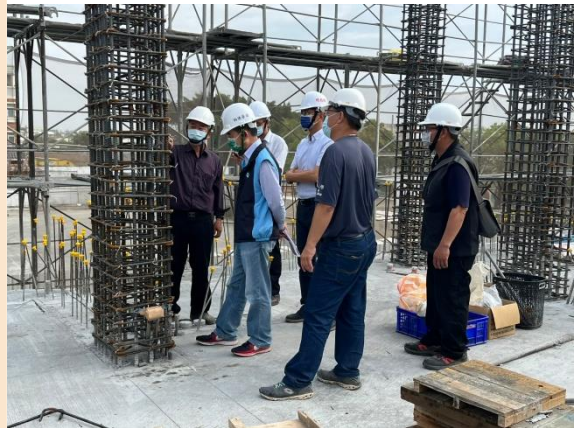
東興國小校舍拆除重建工程現場督考
