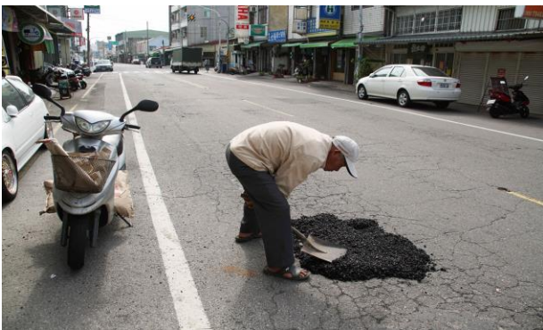
106年梅姬颱風襲台後，里內道路破損，里長到公所領取瀝美土後親自修補坑洞。
