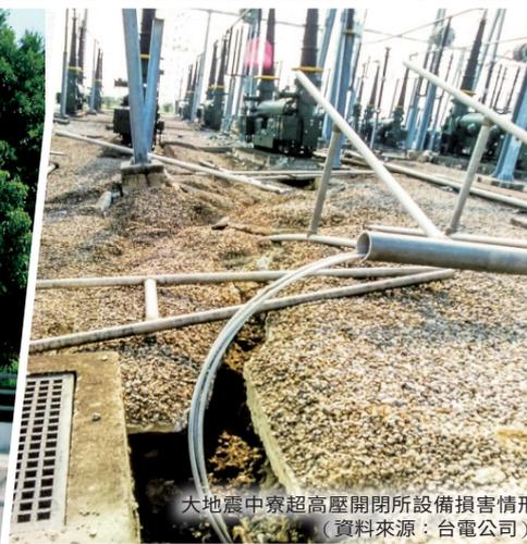
大地震中寮超高壓開閉所設備損害情形（資料來源：台電公司）
