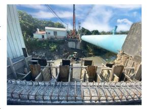
考量當地地層相關力學參數設計,設計採不落墩之 [型預鑄鋼樑橋設計,以增加菜寮溪通洪斷面,寬度由 4.5 公尺增寬為 6.1 公尺,長度
