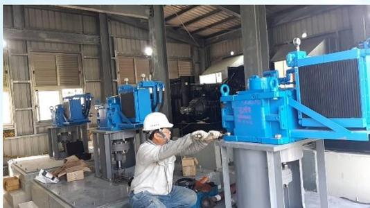
重力排出，故設置正義抽水站，採機械抽排低地排水及側溝排水以減輕積淹水情事，主要匯集忠義路箱涵及正義三街北側截流箱涵抽排入三爺溪，集水面積約 60 公頃，
