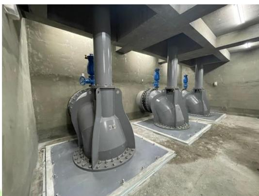
護成本日益增高，遂提出站內抽水機組設備更新。臺南市仁德區「正義抽水站應急抽水機組及附屬設施更新改善工程」，預計將 3 部抽水機組由 2.0CMS 更換 2.3CMS，另抽水站後方平臺配置 2 部 0.5CMS 移動式抽水機增加抽排量，共計抽
